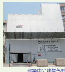
建築中の建物外観
