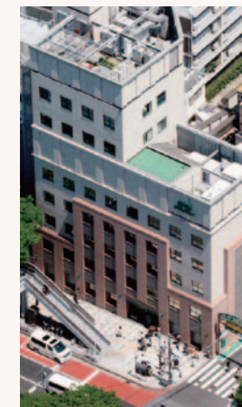
平成9年(1997年)渋谷区神宮前新築建物竣工。 —平成22年(2010年)6月撮影—
