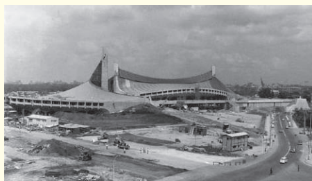
建設中の代々木競技場 提供：渋谷区
