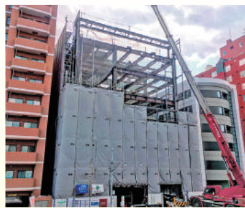
各フロアの床も完成し、工事は順調に進んでおります。
